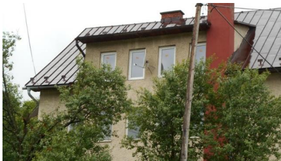
DOS s novými plastovými oknami
