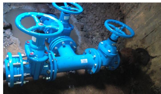
Zrekonštruovaný vodojem Dúbravy
