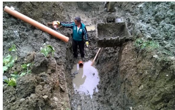
Inštalácie kanalizačnej prípojky OcÚ
